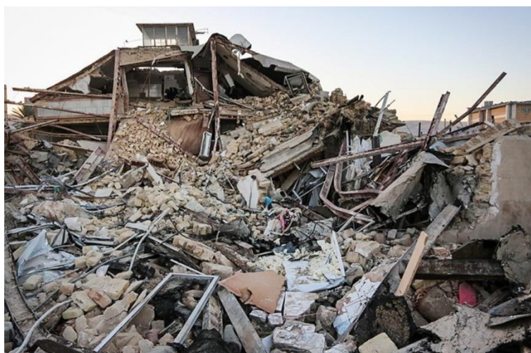
شکل ۱-۳: تصویری از ساختمان فرو ریخته در سریل دهاب پس از زلزله ۱۳۹۶
