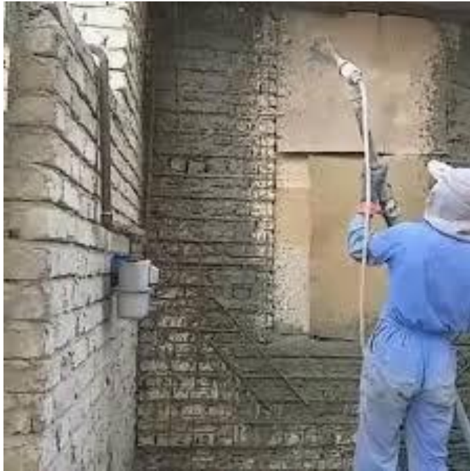
شکل ۲۸ نمونه‌ای از اجرای بتن پاشی روی شبکه فولادی
