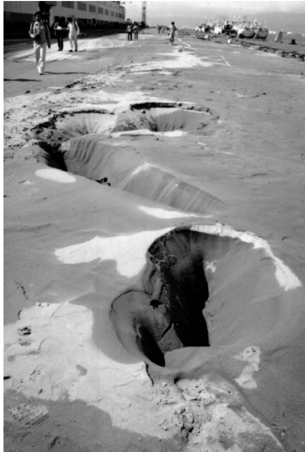
شکل ۲-۴- شواهدی از جوشش ماسه ناشی از روان‌گرایی در بندر هاکوداته ۱ ژاپن در طی زلزله هوکایدونانسی-اوکه ۲ در سال ۱۹۹۳.
