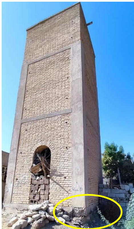
تصویر ۵۰ سازه بتنی منبع آب در روستای سرزه
