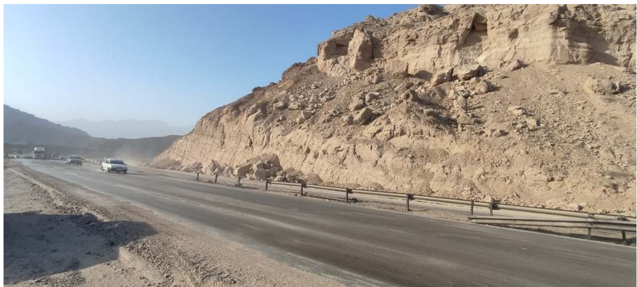
تصویر ۱۰۱ ناپایداری قطعات سنگی شیب مجاور جاده در نزدیکی تونل شهید میرزایی
