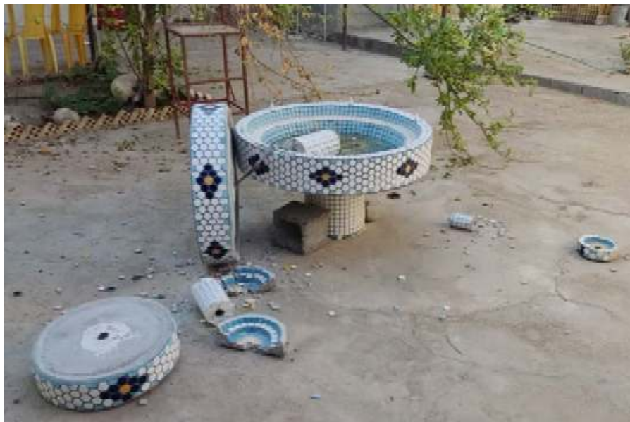
تصویر ۷۸ حوض مطبق تخریب شده در حیاط روستای سرزه
