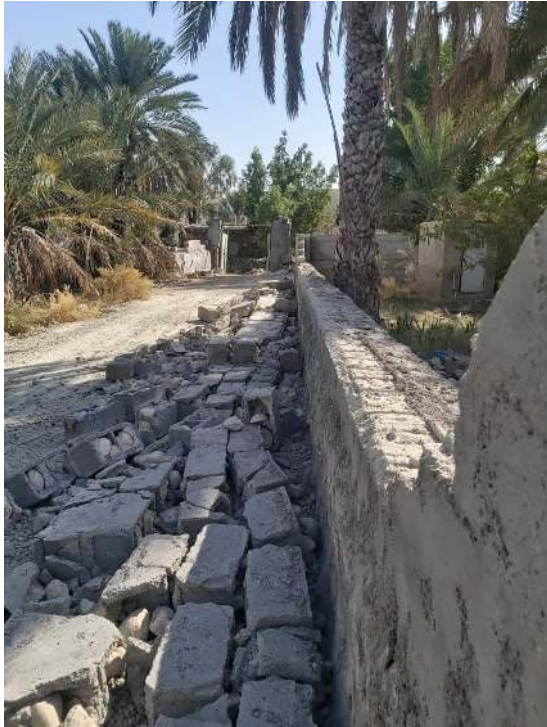
تصویر ۶۸ ریزش دیوار پیرامونی اجرا شده با بلوک سیمانی با ملات و بدون ملات (خشکه چینی) در روستای مزرا
