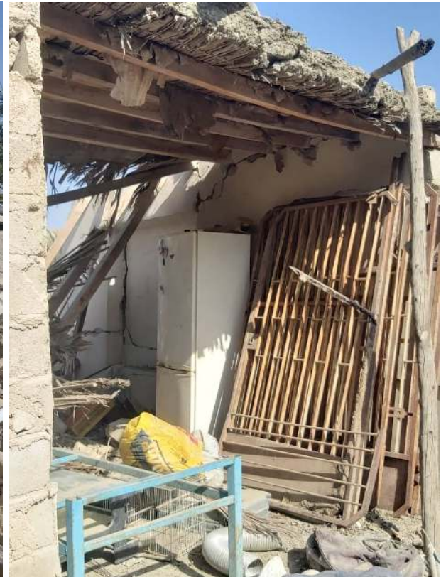
تصویر ۳۱ ریزش دیوار و سقف خانه‌های خشتی و گلی در روستای مзира
