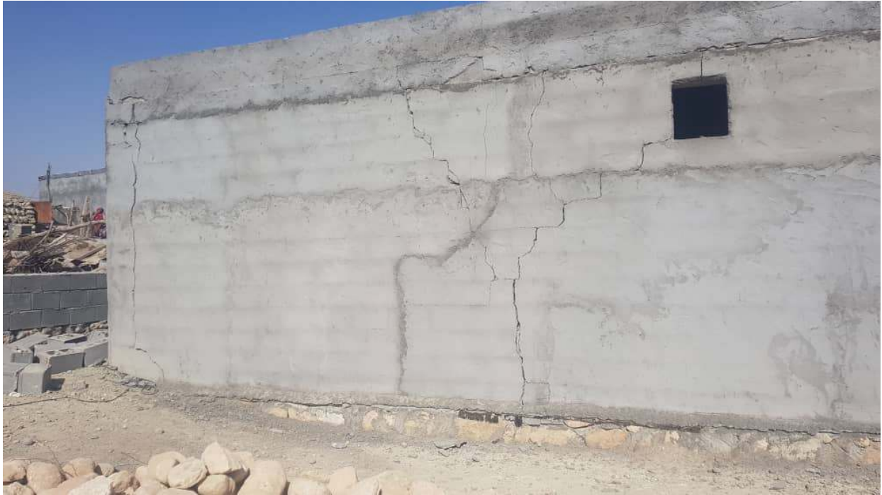
تصویر ۱۶ ترک‌های قطری و قائم در دیوار فاقد کلاف در روستای مزرا
