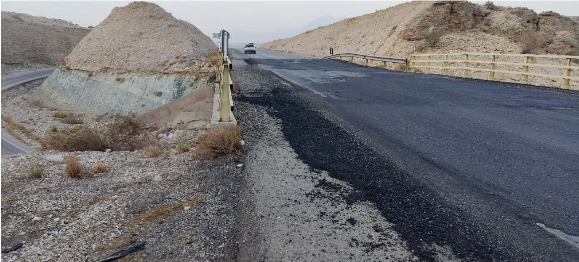
تصویر ۹۸ روکش موقت برای پر کردن ناهمواری و ترک‌های پل
