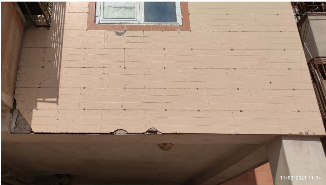
تصویر ۶۲ نگهداری نمای سرامیکی با رول پلاک در شهر بندرعباس
