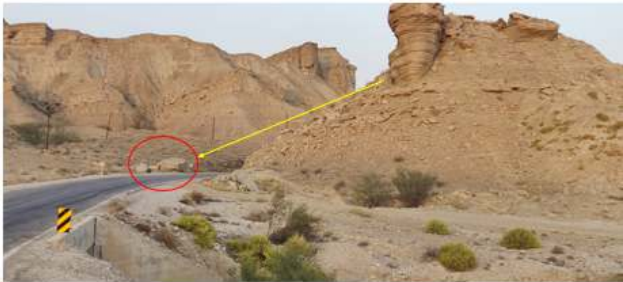
تصویر ۱۰۲ ریزش کوه و پتانسیل بالقوه ریزش مجدد در مجاورت جاده روستای سیاهو
