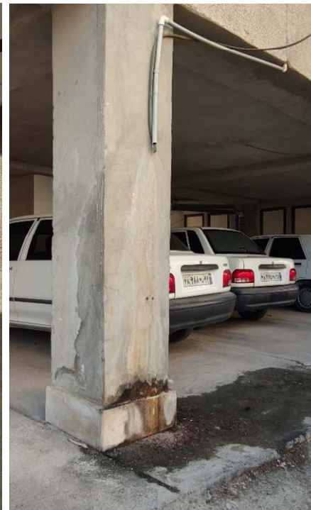
تصویر ۵۴ خوردگی ستون‌های بتنی و فونداسیون سازه به دلیل هدایت اشتباه آب کولرهای گازی، لوله‌های آب باران و کف شور بالکن‌ها در پای ستون در مجتمع‌ها (بندرعباس)
