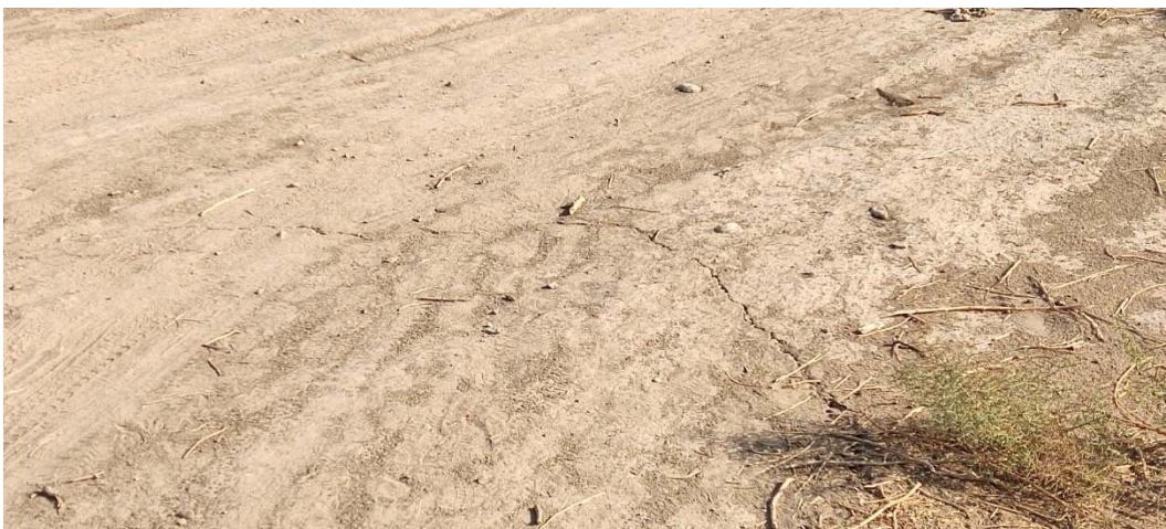
تصویر ۱۲ ایجاد گسلش سطحی زمین در اثر زلزله در روستای سرزه
