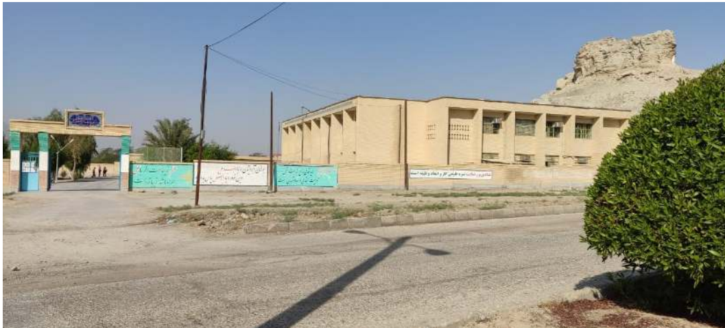
تصویر ۳۸ عدم آسیب دیدگی سازه و نمای مدرسه اسکلت بتنی در شهر فین
