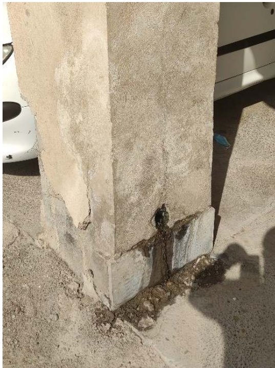
تصویر ۵۴ خوردگی ستون‌های بتنی و فونداسیون سازه به دلیل هدایت اشتباه آب کولرهای گازی، لوله‌های آب باران و کف شور بالکن‌ها در پای ستون در مجتمع‌ها (بندرعباس)
