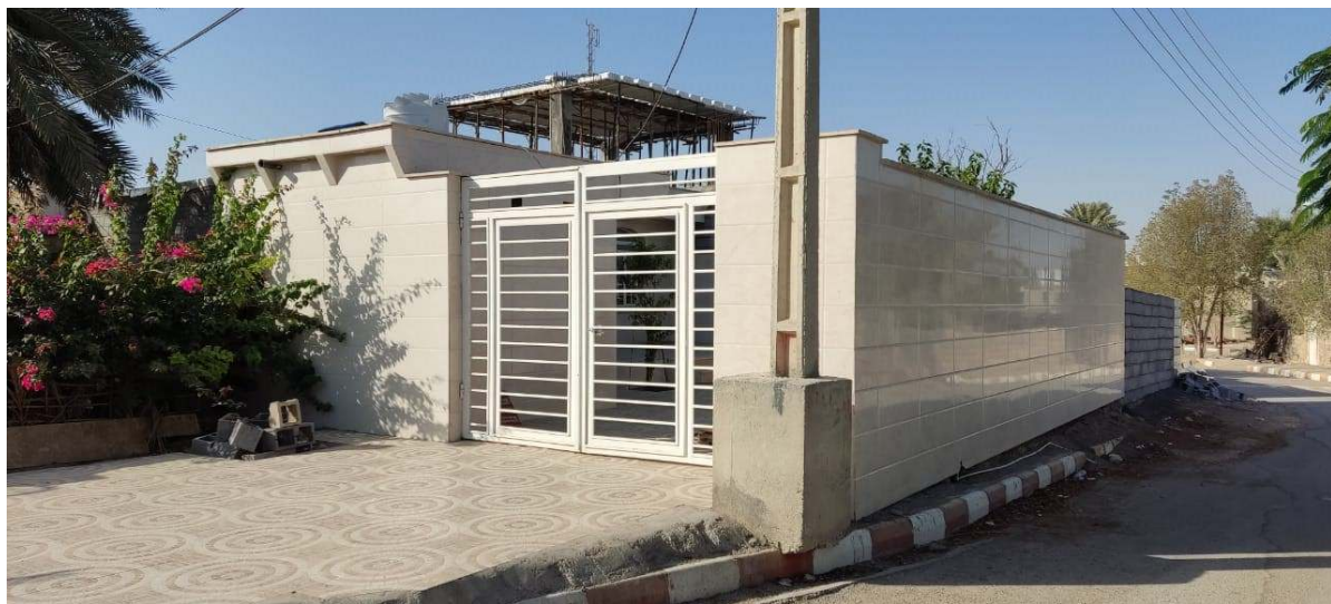
تصویر ۴۱ سالم ماندن سازه و نمای ساختمان دارای شناژ در روستای سرزه
